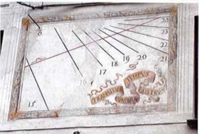
Nella pagina precedente: Particolare della facciata appena restaurato. Sopra: Le varie fasi del restauro.
